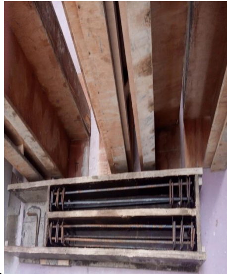
Ξυλότυποι παρασκευής δοκών οπλ. σκυροδέματος.
